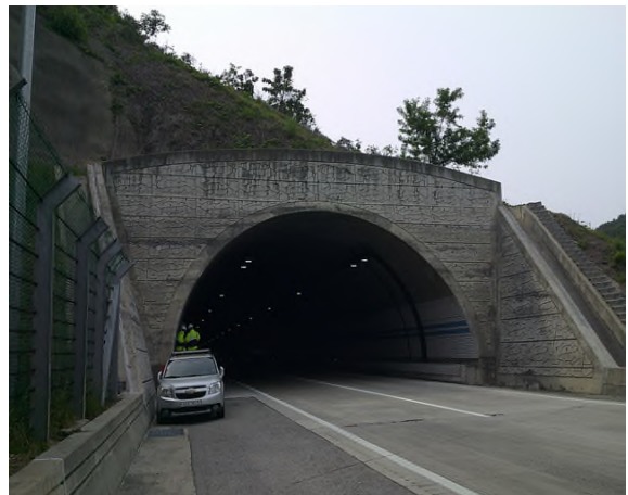
4공구 평호터널(상주방향) (4공구) 종점부
