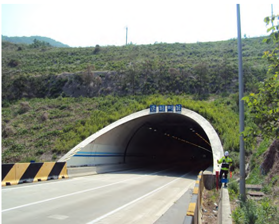
3공구 군위터널(영천방향) (3공구) 시점부
