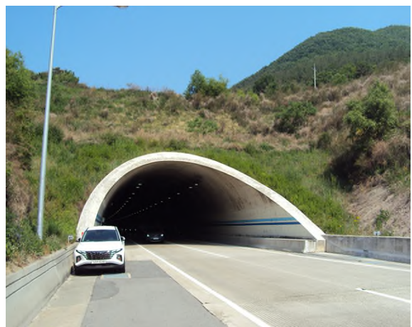
3공구 군위터널(영천방향) (3공구) 종점부
