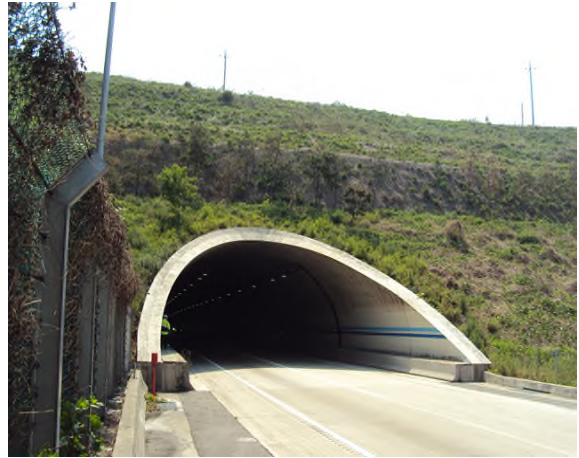
3공구 군위터널(상주방향) (3공구) 종점부
