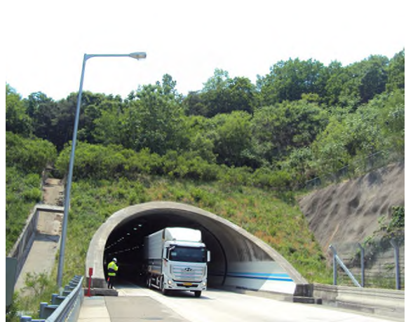
4공구 산법터널(상주방향) (4공구) 종점부
