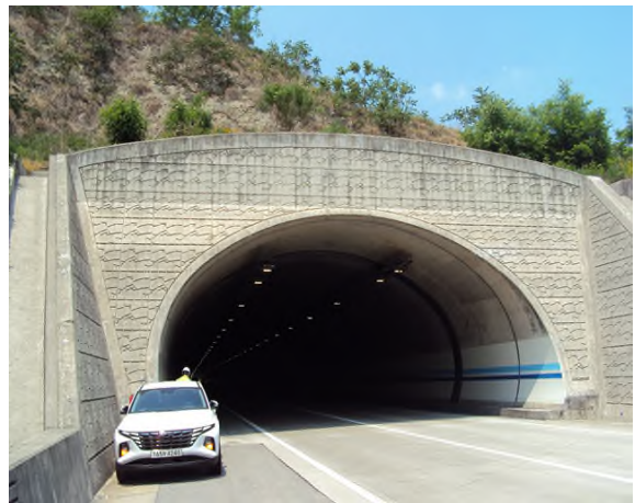
5공구 불로터널(영천) (5공구) 종점부
