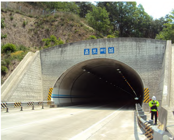
5공구 불로터널(영천) (5공구) 시점부
