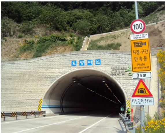
5공구 효령터널(상주방향) (5공구) 시점부
