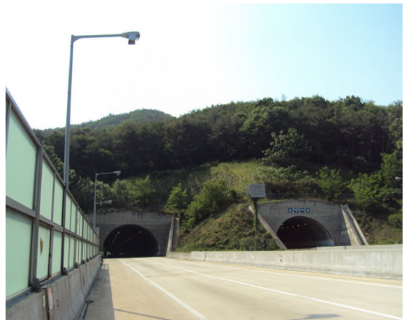
5공구 효령터널(상주방향) (5공구) 종점부
