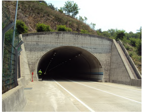
5공구 불로터널(상주) (5공구) 종점부
