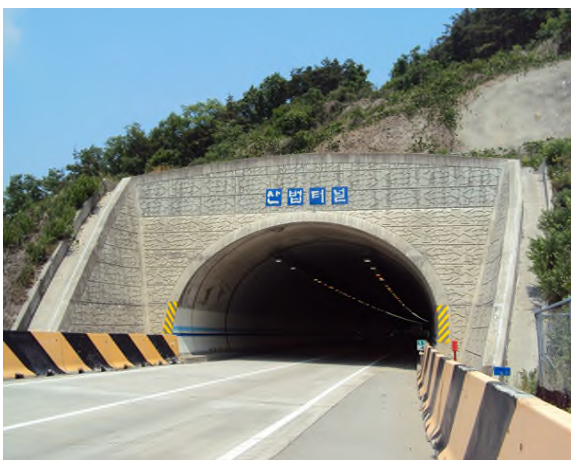
4공구 산법터널(상주방향) (4공구) 시점부
