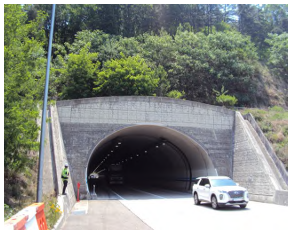
5공구 중구터널(상주) (5공구) 종점부
