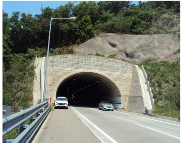
4공구 산법터널(영천방향) (4공구) 종점부
