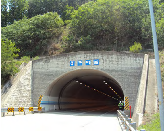
5공구 중구터널(영천) (5공구) 시점부
