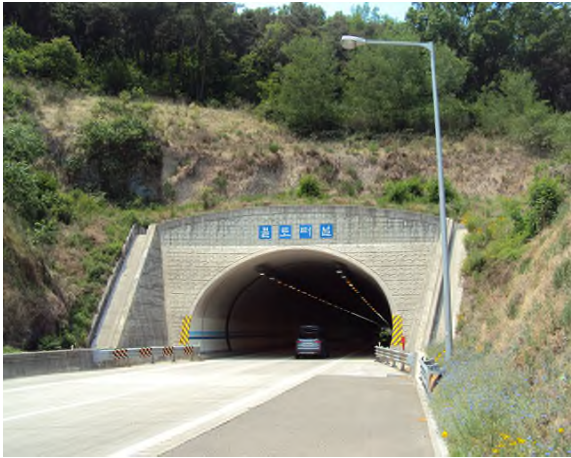
5공구 불로터널(상주) (5공구) 시점부
