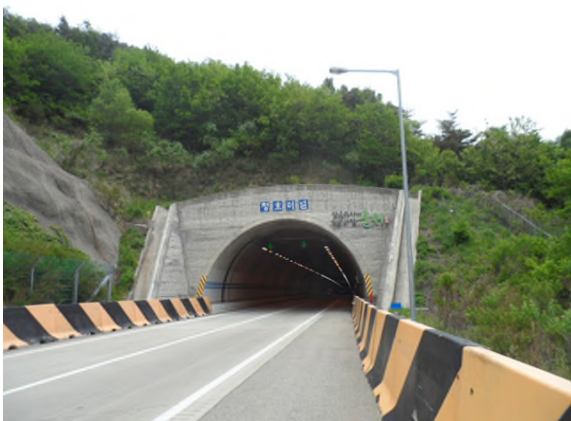
4공구 평호터널(영천방향) (4공구) 시점부
