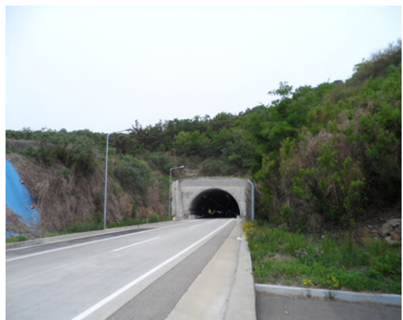
4공구 평호터널(영천방향) (4공구) 종점부
