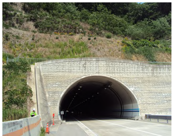
5공구 효령터널(영천방향) (5공구) 종점부
