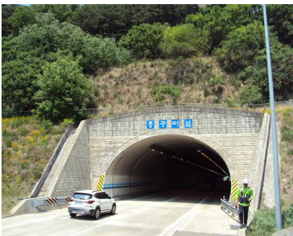
5공구 중구터널(상주) (5공구) 시점부
