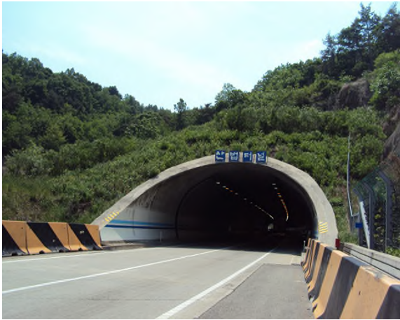
4공구 산법터널(영천방향) (4공구) 시점부
