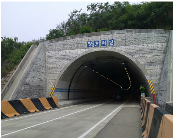
4공구 평호터널(상주방향) (4공구) 시점부
