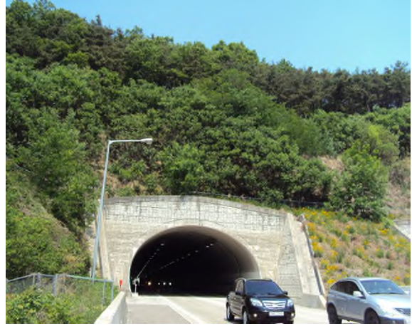
5공구 중구터널(영천) (5공구) 종점부
