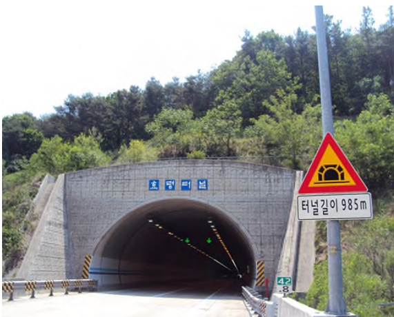
5공구 효령터널(영천방향) (5공구) 시점부
