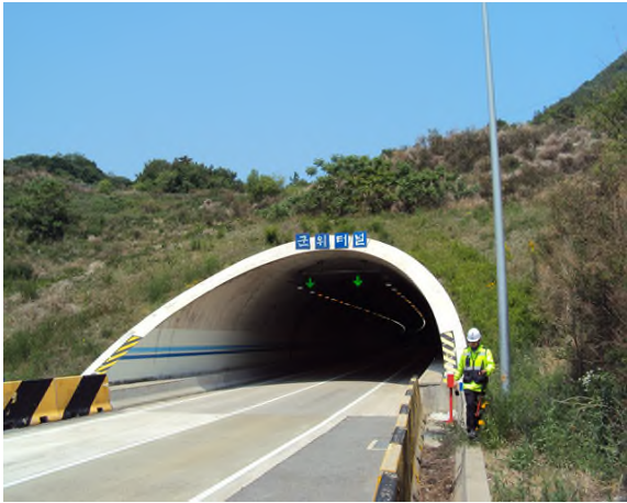
3공구 군위터널(상주방향) (3공구) 시점부
